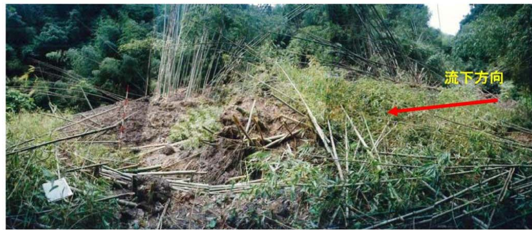
地すべり性崩壊の末端部に発生した土石流
